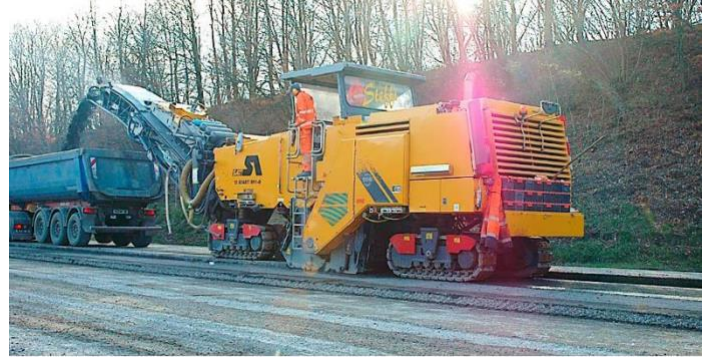
Рисунок 6. Фрезерування існуючого асфальтобетонного покриття
