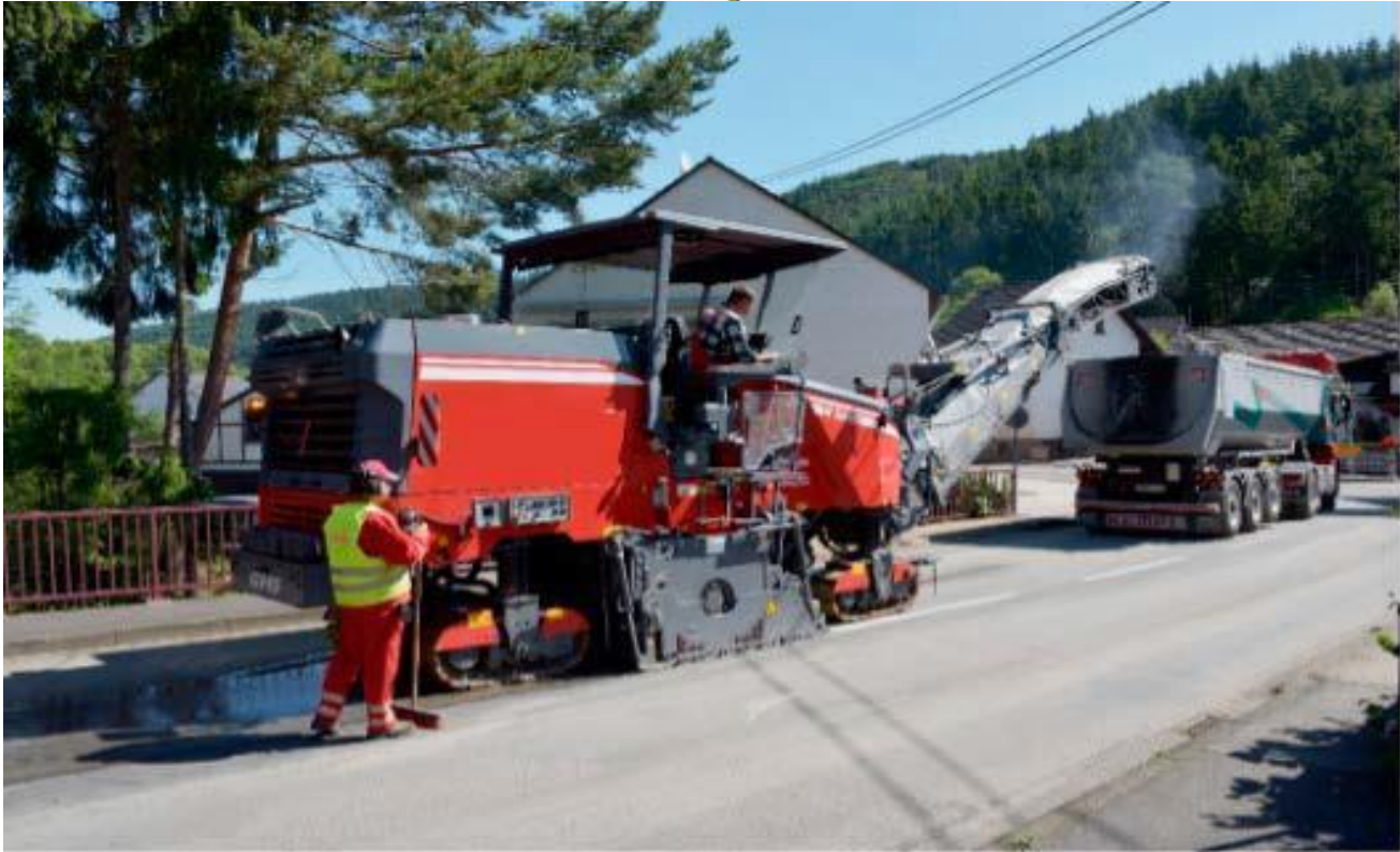
Рисунок 4. Фрезерування існуючого асфальтобетонного покриття з метою вилучення матеріалу та його повторного використання при будівництві та утриманні новихдоріг
